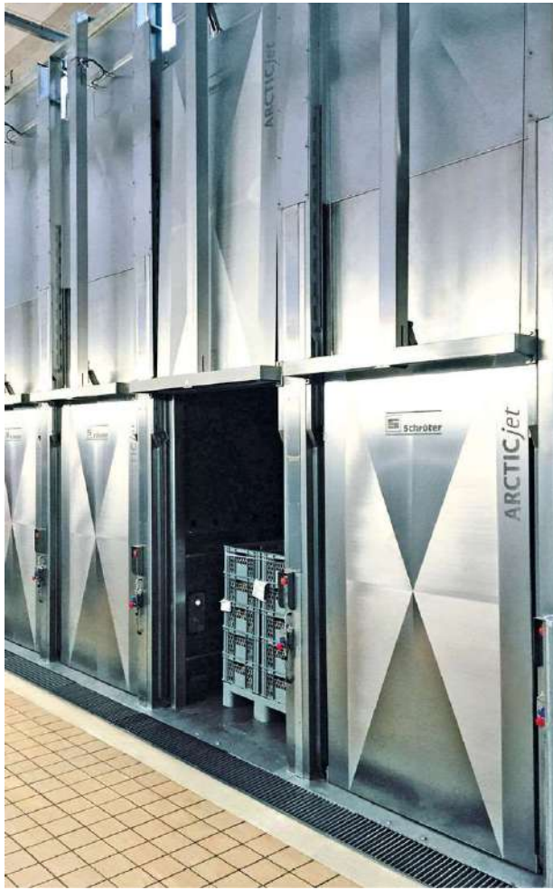
Instalație de răcire intensivă cu aer rece - uși culisante pe verticală
