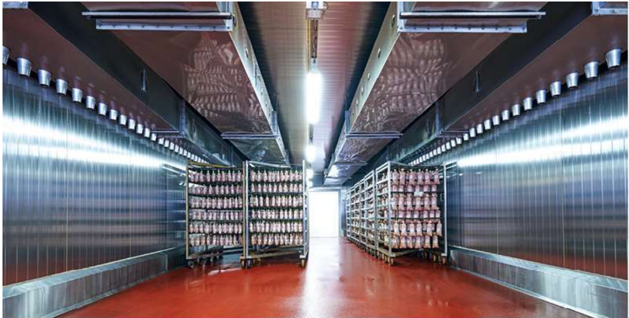
Sistem de tubulaturi de aer multiple cu curgere orizontală și verticală
